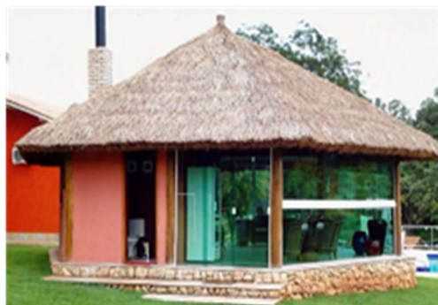
Edificação com cobertura de fibras vegetais
